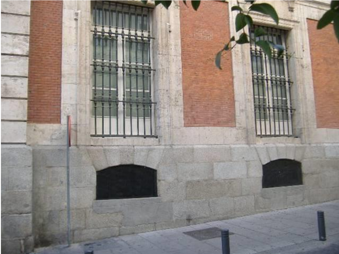
Ventanas de la Real Casa de Correos de la fachada de la calle del Correo, lugar en el que se situaba el buzón del llamado Primer Alcance.
