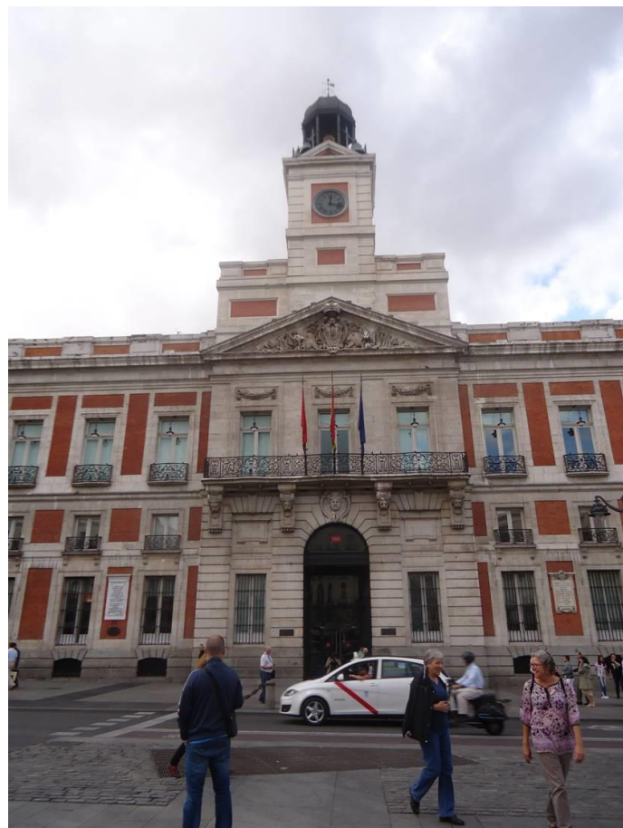
DERECHA : Fachada principal de la Real Casa de Correos.
