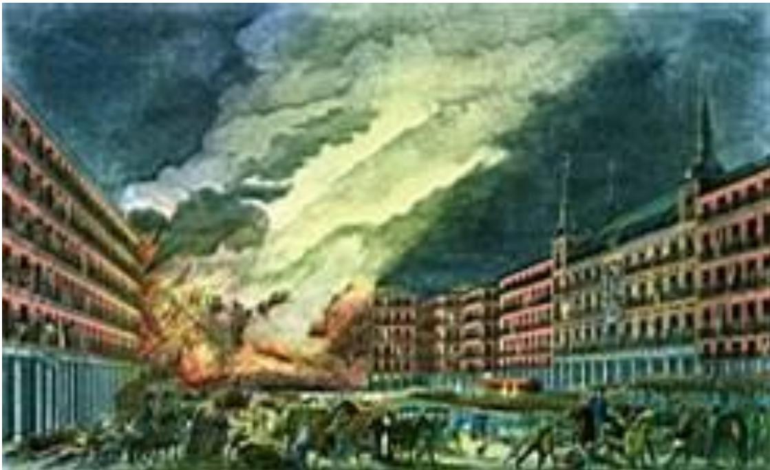
Grabado de época que muestra el pavoroso incendio que, iniciado el 16 de agosto de 1790 d.C., destruyó gran parte de la antigua Plaza Mayor de Madrid.
