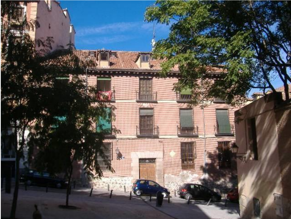
Edificio situado en la Plaza de la Paja que se alza sobre el solar en que se levantaba la casa de Rui González de Clavijo, embajador del rey Enrique III de Castilla a la corte del Khan Tamerlan.
