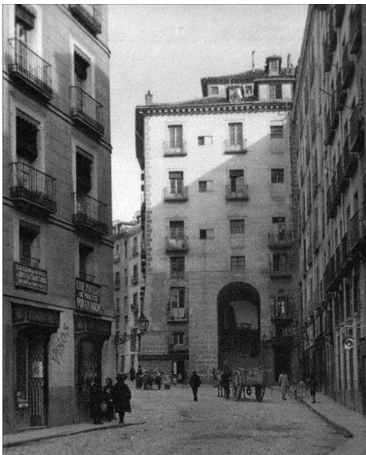
DERECHA : Imagen de la calle de Cuchilleros fechada en el año 1919 d.C.
